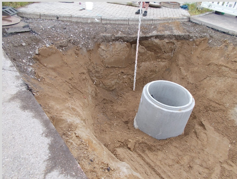
Beispiel Aushub anthropogene Auffüllung (Sandbett) in Baugrube auf Leopoldshafener Allee am 28.07.2021 (Schurf SX – s. Abb. 2)
