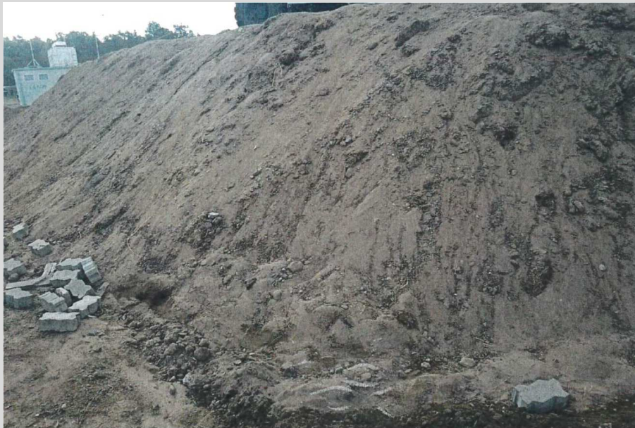
Beispiel Aushub anthropogene Auffüllung einer Erdbaumaßnahme auf dem Campus Nord 2020 (Projekt ELAB).
